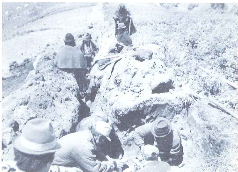
Enterrando la tubería.
