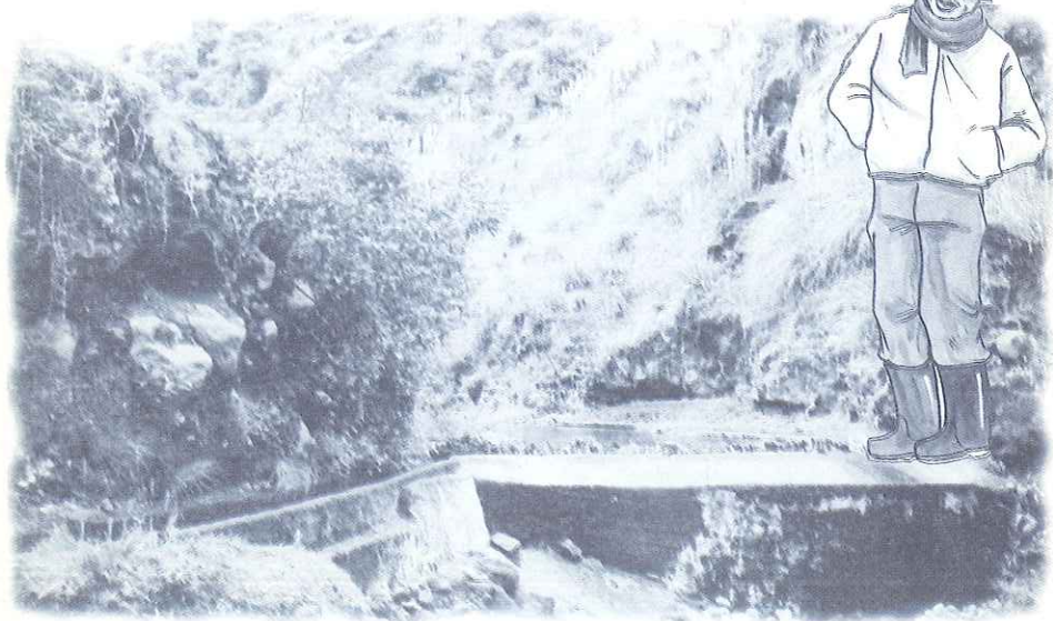
Bocatoma de la quebrada de Huagra Corral.
